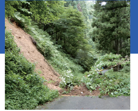
■中山間地の土砂崩れによる通行止め
