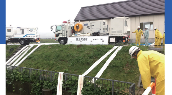
■国交省と市のポンプ車による排水作業(婦中町磯川)
